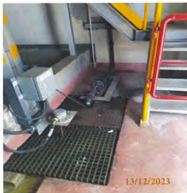
รูปที่ 3-54 Emergency Drain
