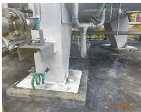
รูปที่ 3-61 อุปกรณ์กักเก็บและลำเลียง ต่อเข้ากับระบบสายดิน
