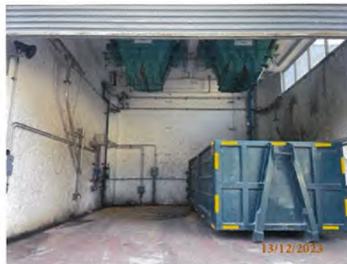
รูปที่ 3-12 การเก็บรวบรวมตะกอน จากระบบบำบัดน้ำเสีย
