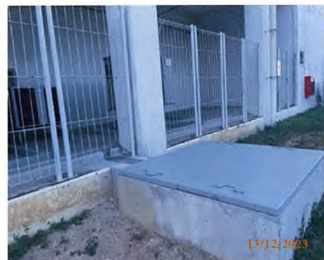
รูปที่ 3-77 ระบบรวบรวมน้ำฝนปนเปื้อน ในบริเวณพื้นที่หม้อแปลงไฟฟ้า
