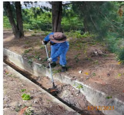
รูปที่ 3-19 การขุดลอกรางระบายน้ำ
