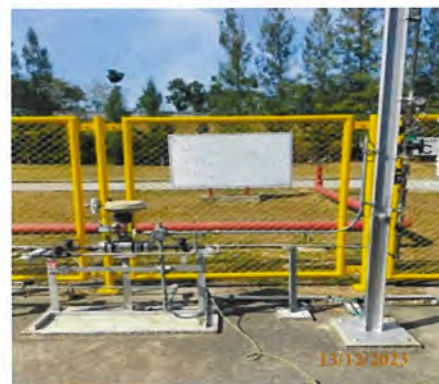
รูปที่ 3-62 อุปกรณ์ป้องกันก๊าซไหลกลับในท่อ (Check Valve)
