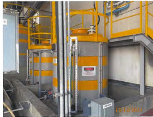
รูปที่ 3-55 การออกแบบให้หน่วยที่มี การใช้สารเคมีเป็นระบบปิด
